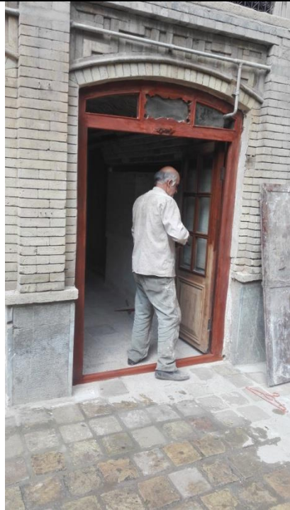
در حال رنگ آمیزی در های چوبی
