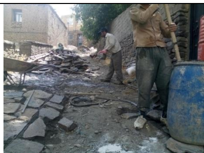
در حال کفسازی
