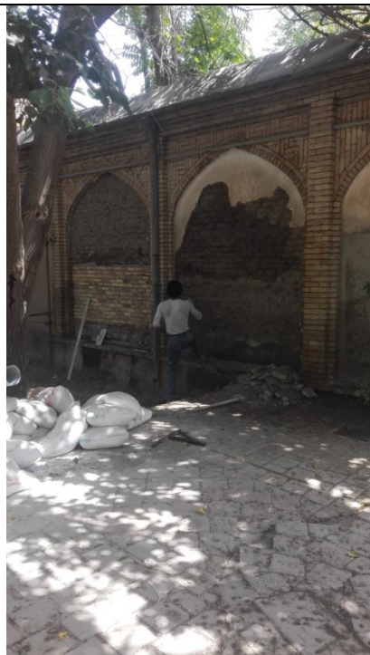
بعد از لایه برداری و در حال اجرای دیوار آجری
