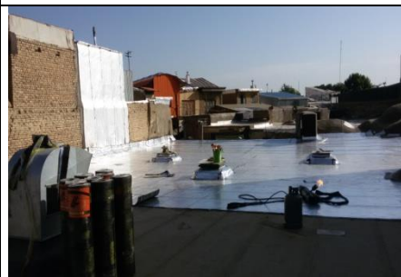
در حال ایزوگام بام
