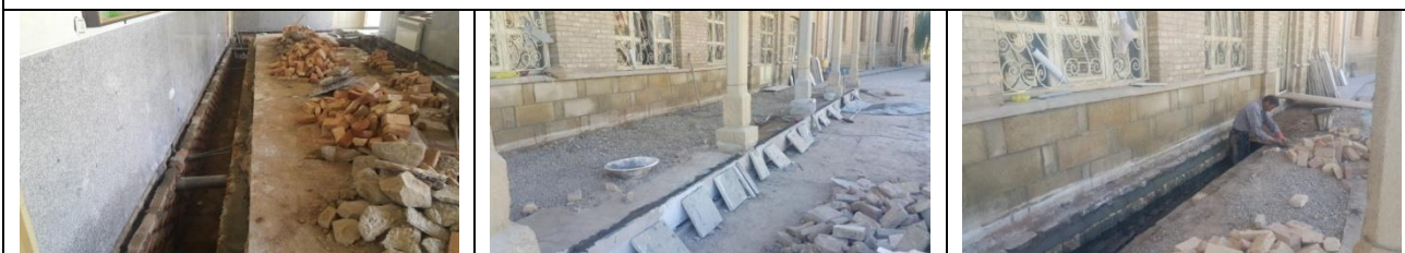
احیای کانال رطوبت گیر و تجدید سنگ فرش مهتابی مدرسه آرامنه
