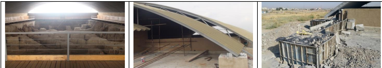
اجرای پوشش تکمیلی جهت ترانشه مرکزی با نضمام خریداری پانل فلزی
