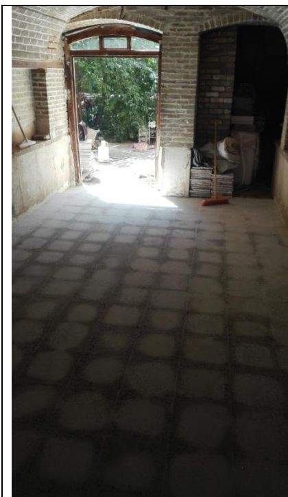
بعد از احداث کانال و کفسازی
