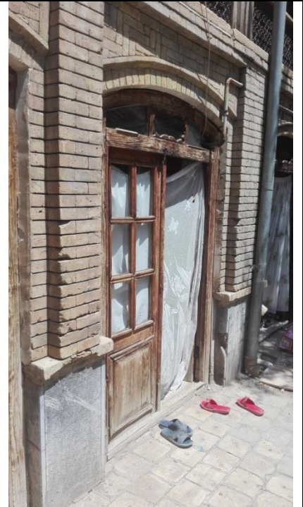
قبل از رنگ آمیزی در های چوبی
